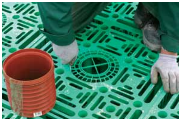
Удаление узорной решетки на отверстии диаметром OD 200 мм, расположенном в верхней части блока
